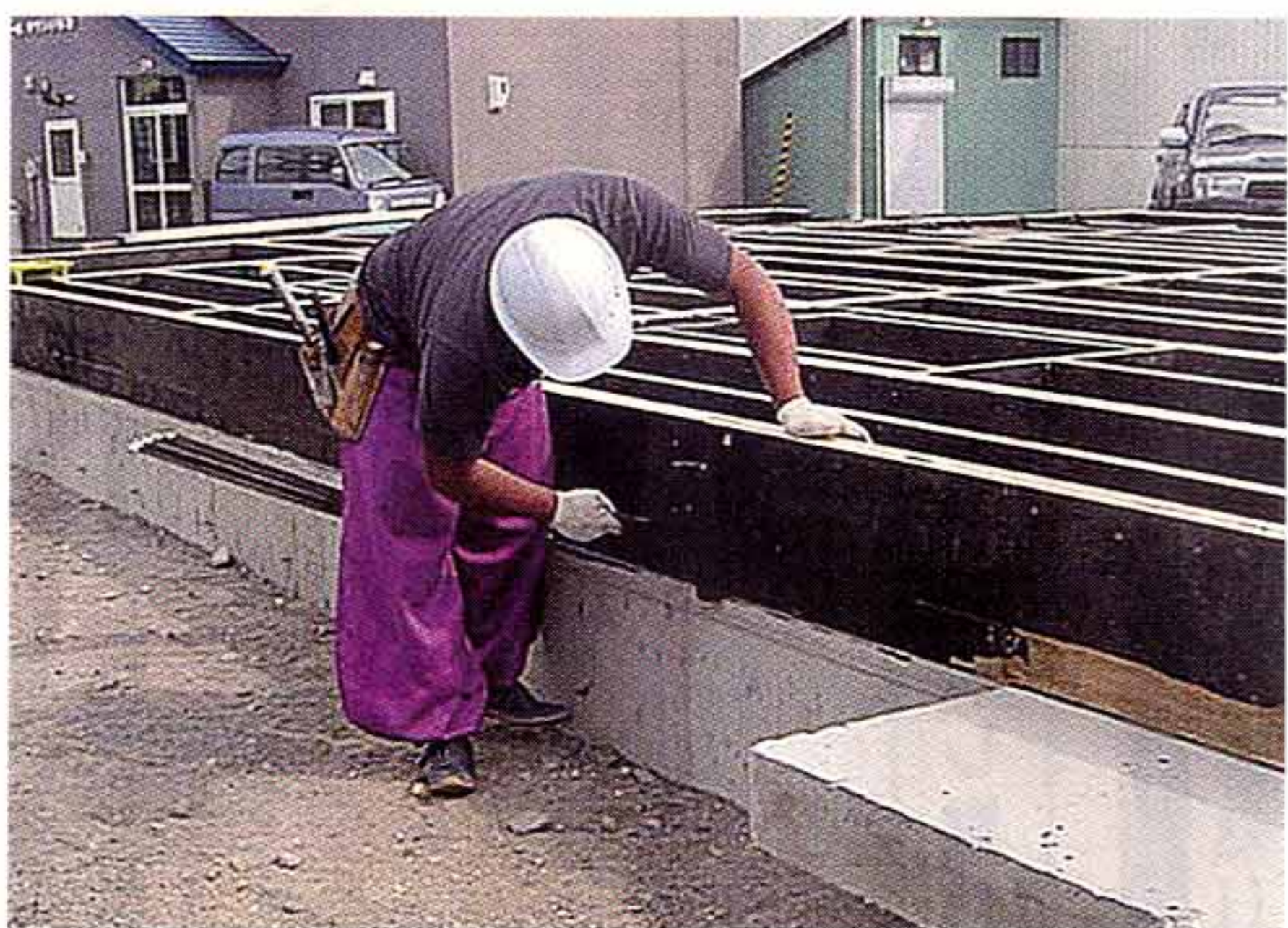
現場で未塗装部分を塗布しているところ
