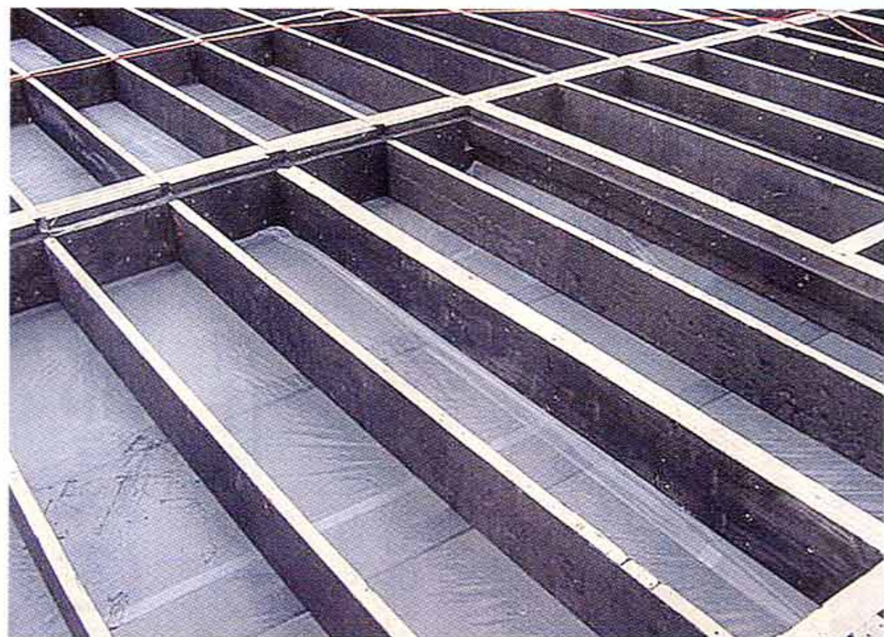
スーパーカーボンコートを塗布した1階床組
