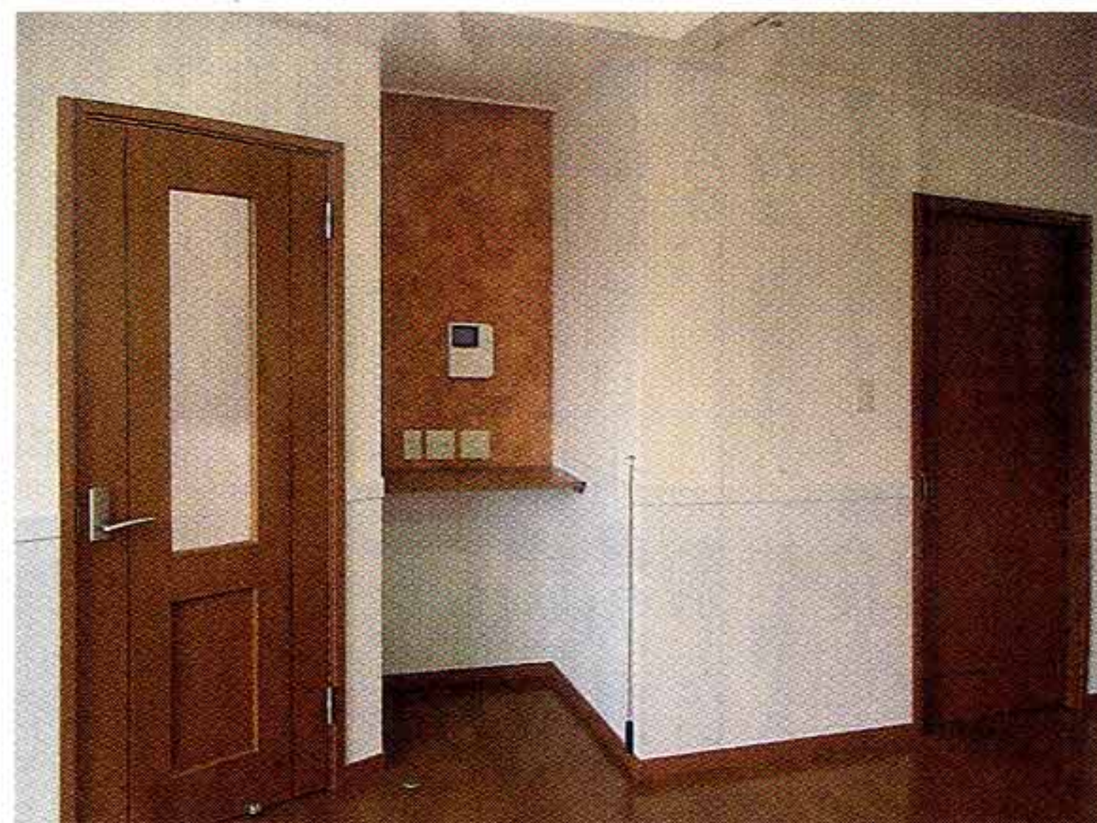
腰壁にモイスを施工した室内
