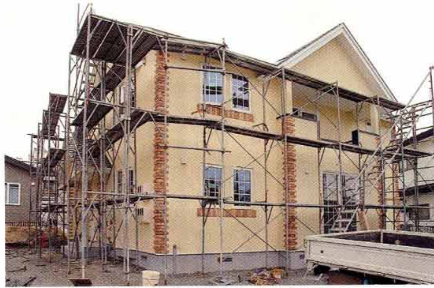
NSアートパレで外装仕上げを行った現場
