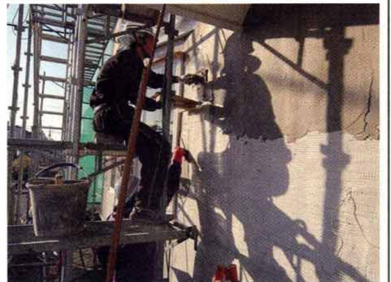
特殊軽量モルタルで下地を造っているところ
